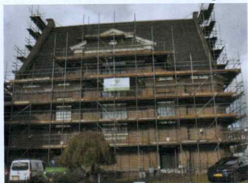
Einde van 2023: De Maartenkerk krijgt een flinke onderhoudsbeurt. Er wordt gevoegd en geschilderd, de zolder wordt opnieuw betimmerd en
